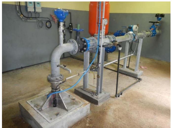
Tête de forage et colonne d'exhaure
