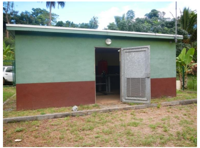
Bâtiment abritant le forage de Béja 2
