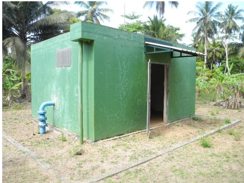
Figure 1 : Local technique du forage Béja 2
