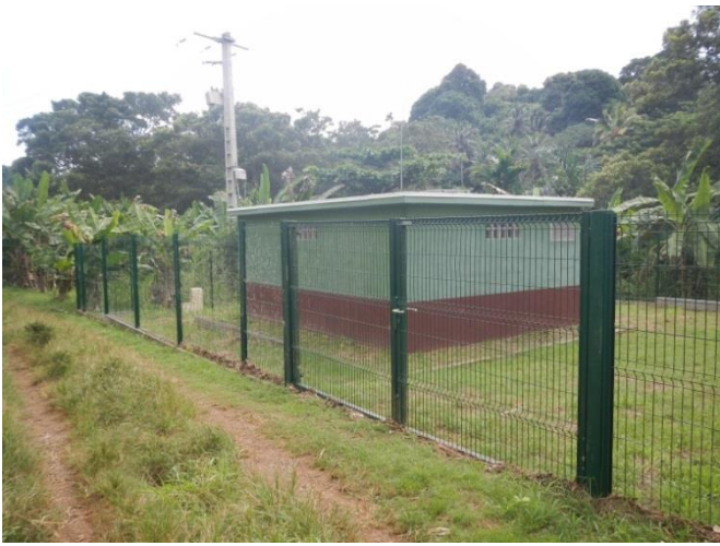
Accès au forage depuis une piste difficilement carrossable
