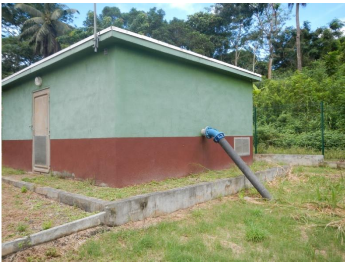
Local de pompage et clôture extérieure
