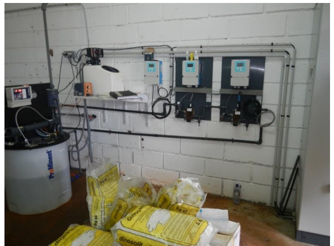
Figure 37 : Vue générale du 'Réservoir 1500' et dispositif de chloration des eaux
